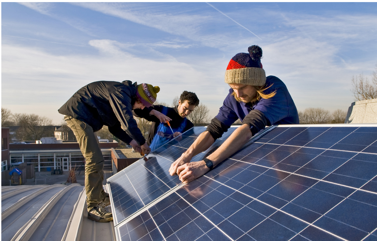
Plaatsen van zonnepanelen
